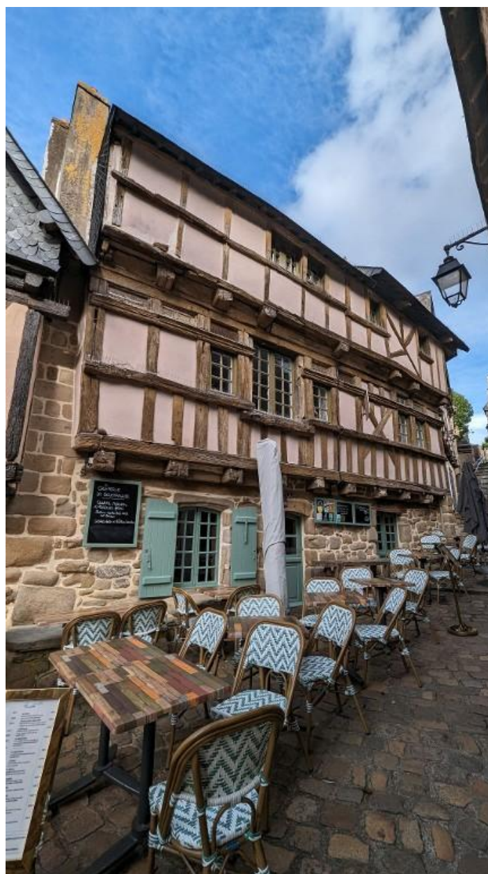
Façade en pan de bois avec encorbellement sur solives, vue depuis la terrasse
