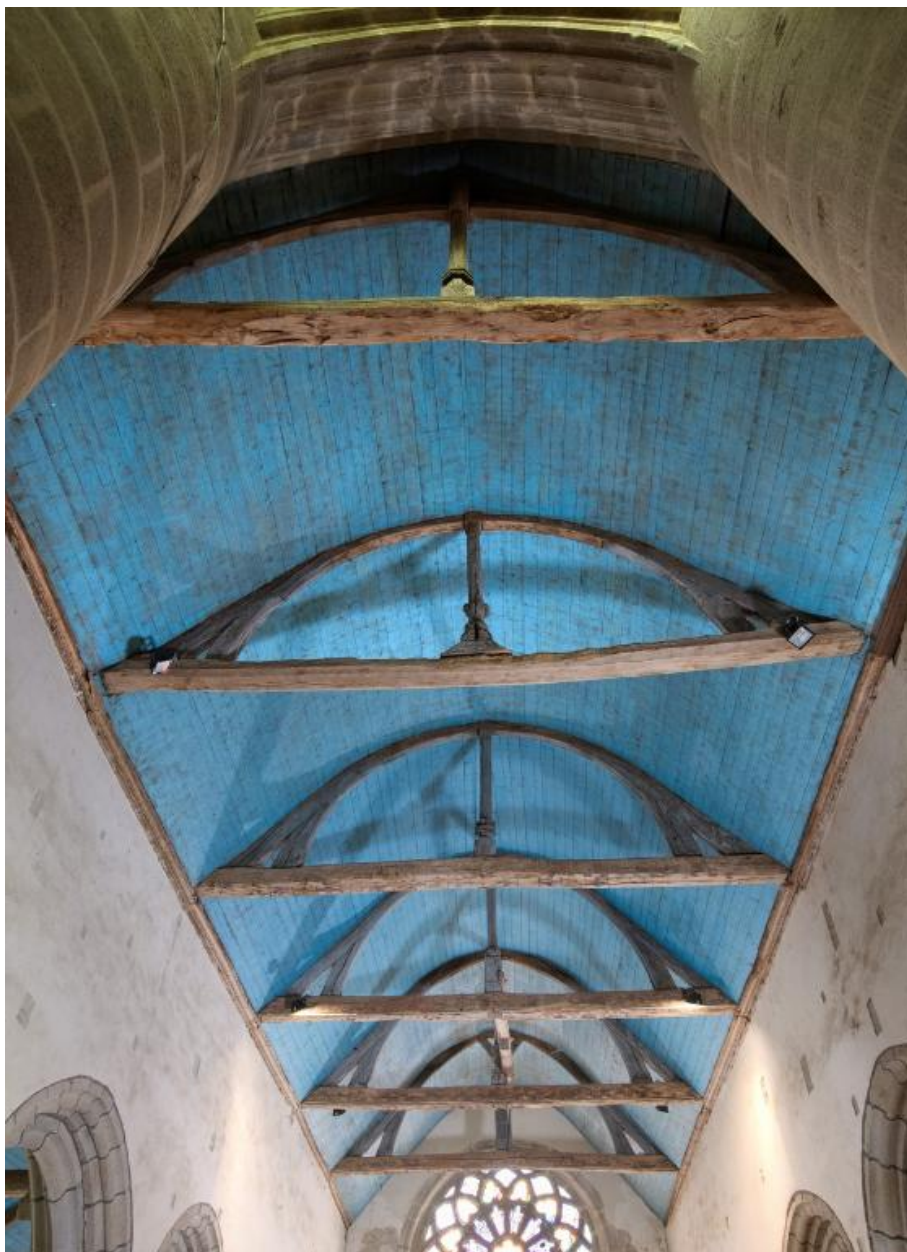
Vue générale de la charpente de la nef
