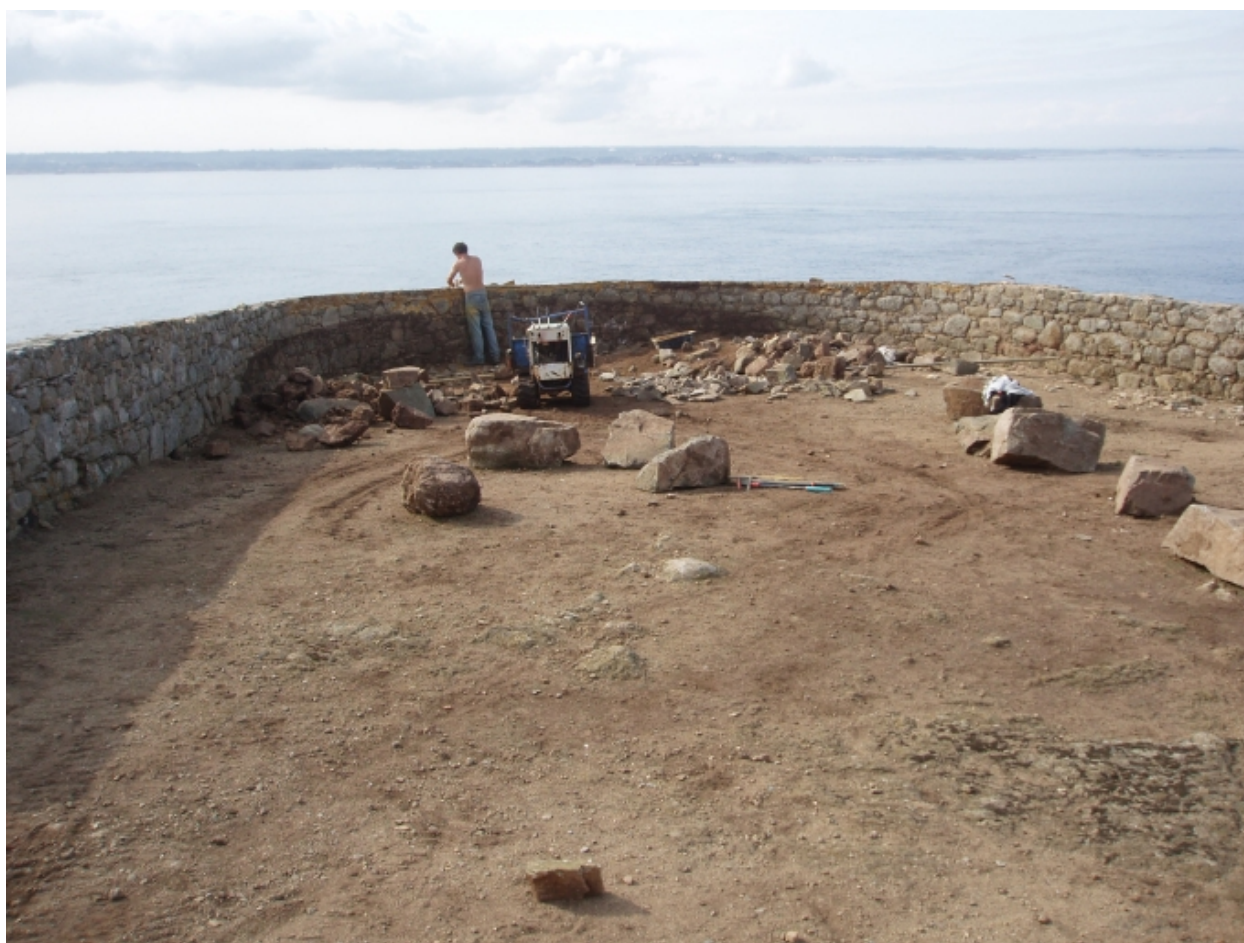
La poterne en cours de restauration (collection particulière)
