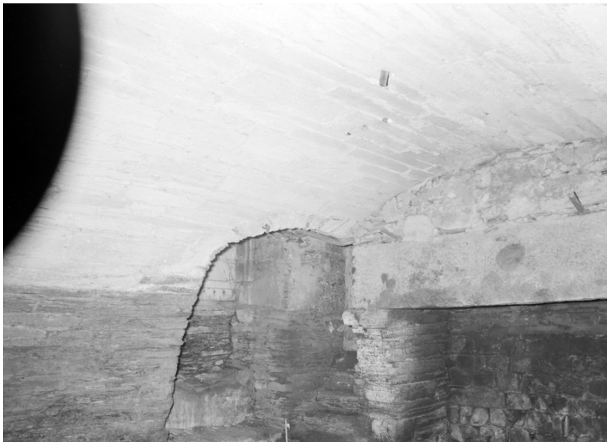
Maison : voûte du sous-sol (état en 1985)
