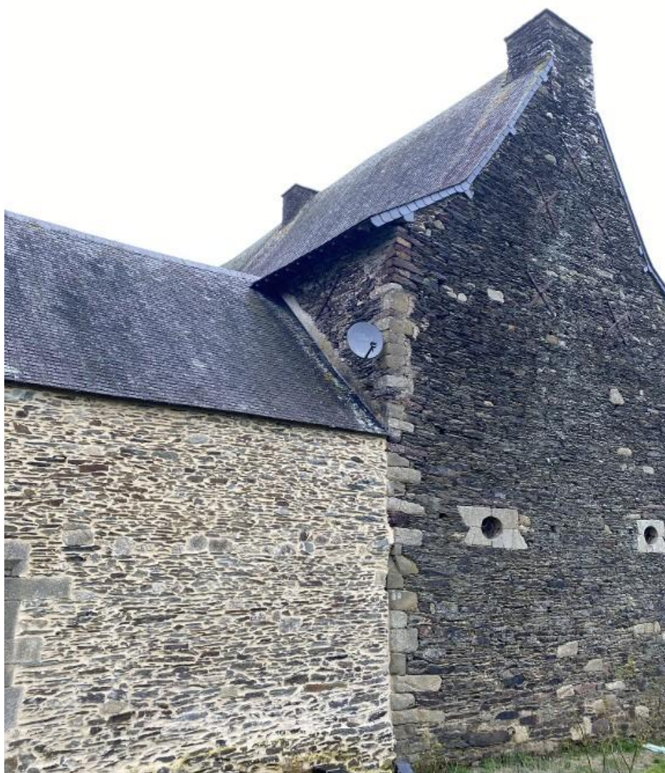
Chaînage d'angle, pignon sud
