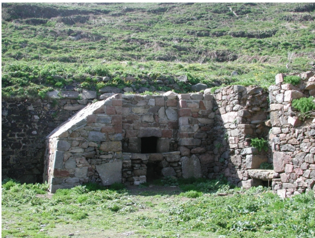
Vestiges de l'ancienne maison du gardien Tassel : remarquer le four à pain
