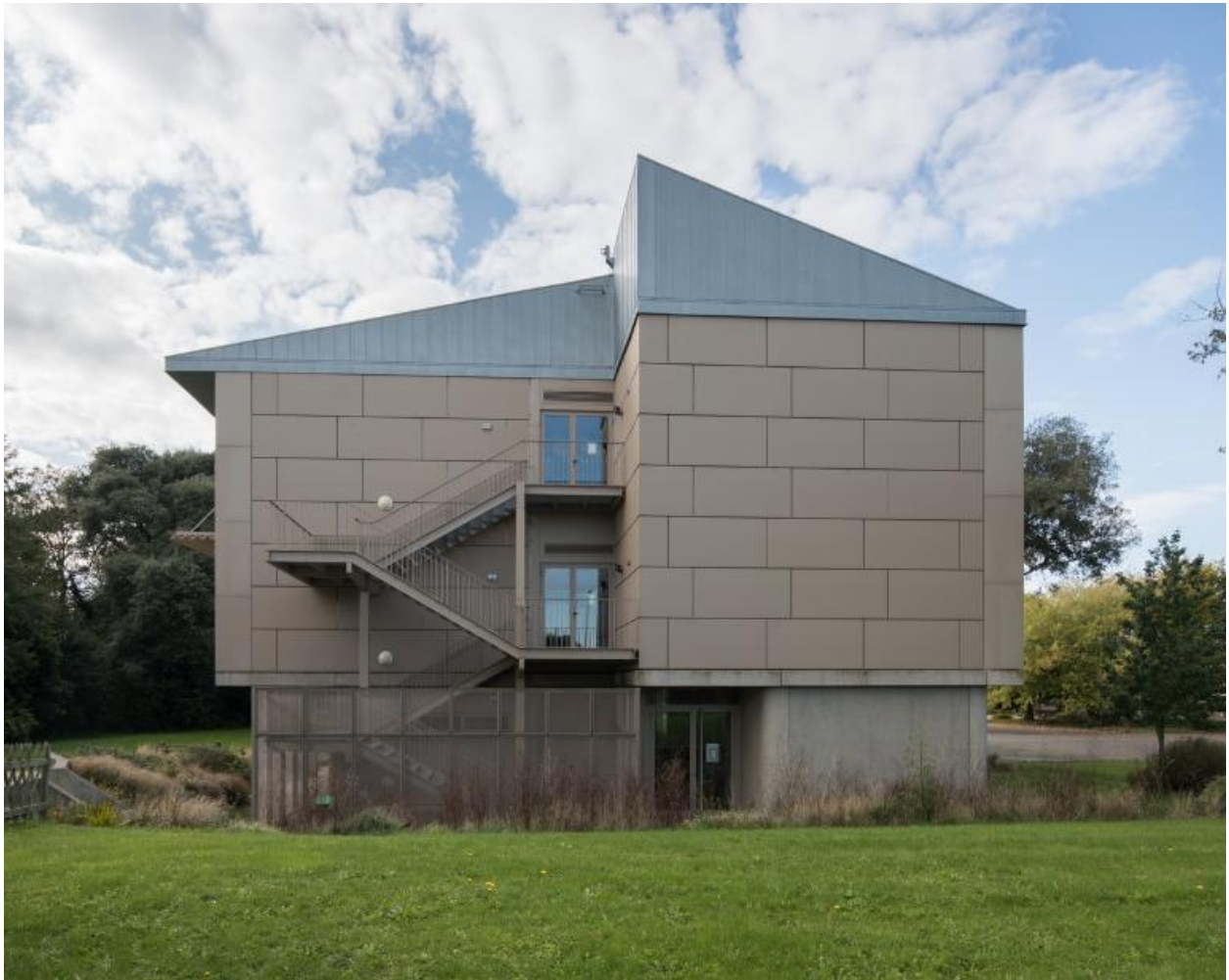
Pignon ouest du pôle sciences (B6). Michel Grignou, architecte, 2010.
