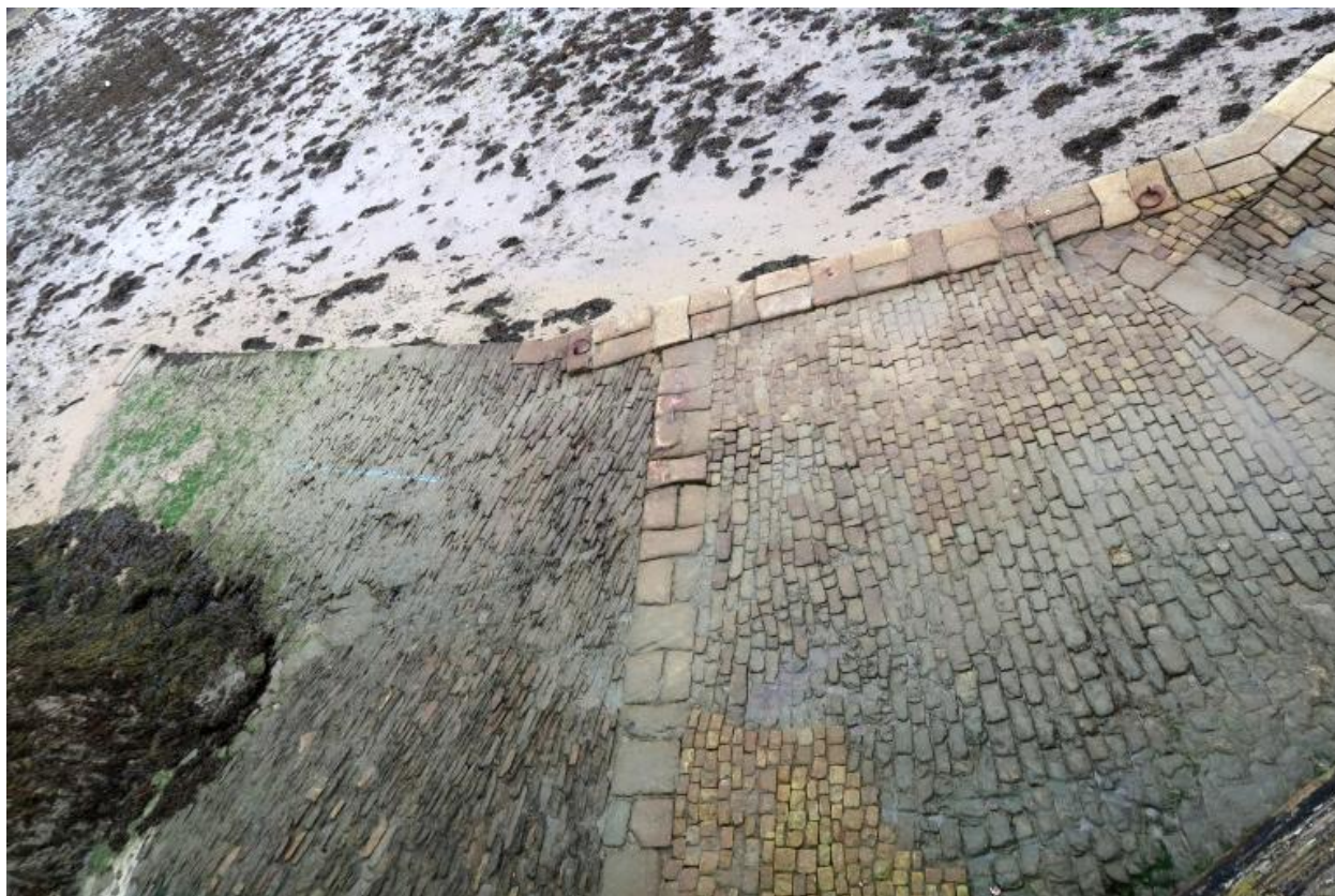
Mise en oeuvre des pavés du platelage de la cale Ouest
