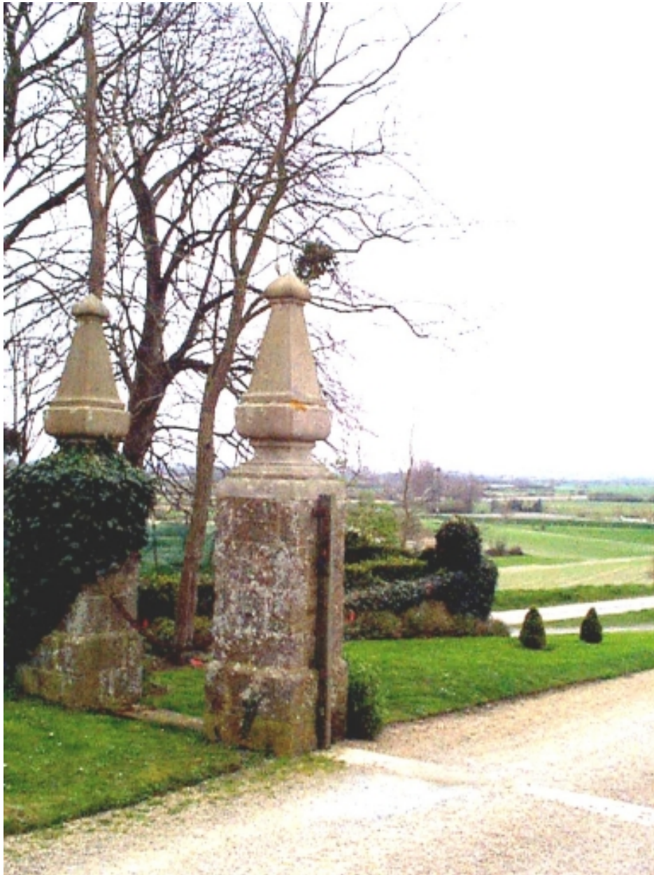
Les piliers d'entrée
