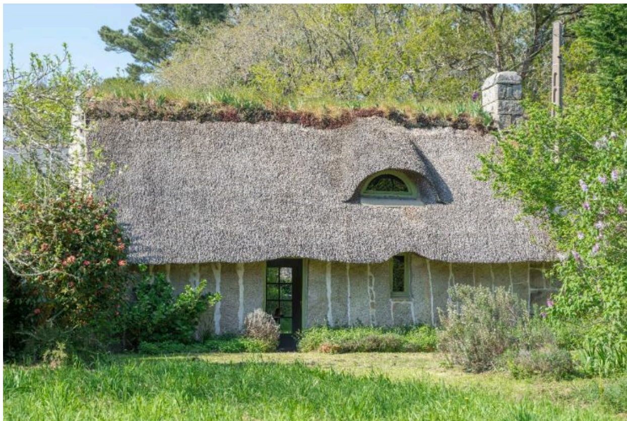
Vue générale de l'élévation antérieure.
