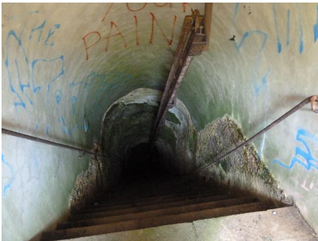
Groix, batterie du Bas-Grognon, escalier du magasin à poudre souterrain.
