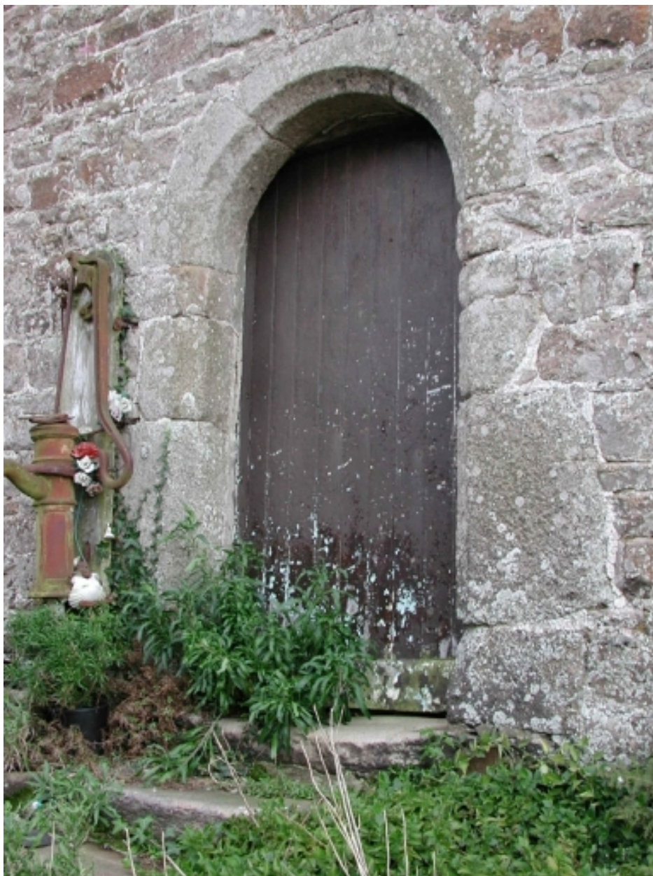
Porte de la façade postérieure.
