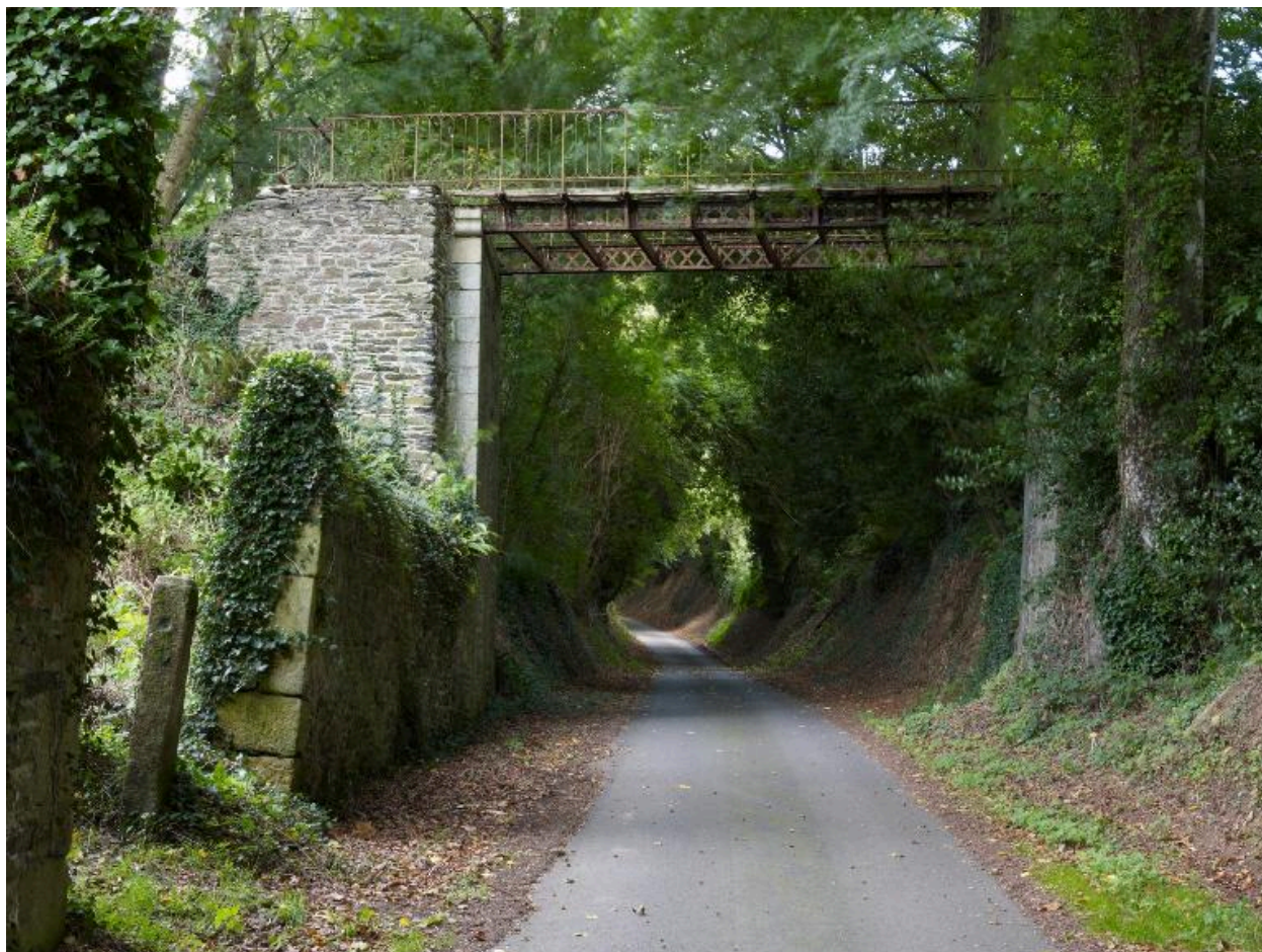
Passerelle métallique. Vue générale
