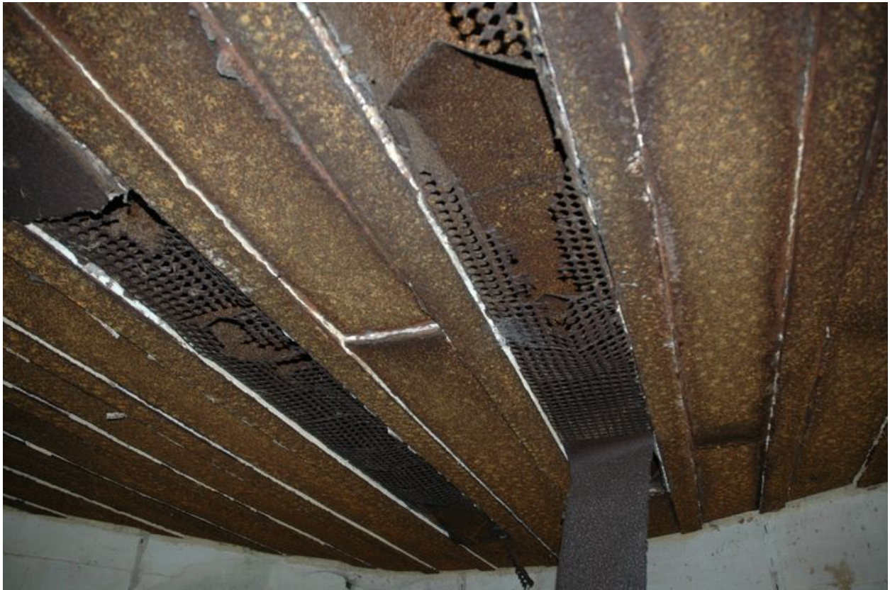
Vue intérieure de l'une des quatre casemates de type 669 : au plafond, bouches d'aspiration des fumées de tir protégées par des grilles (état en 2008)
