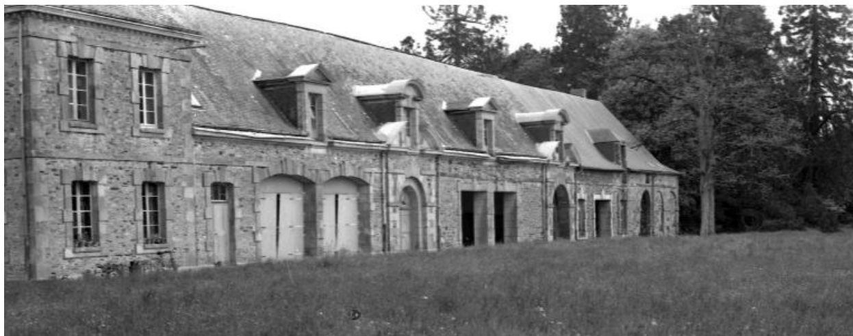
Vue générale des communs.
