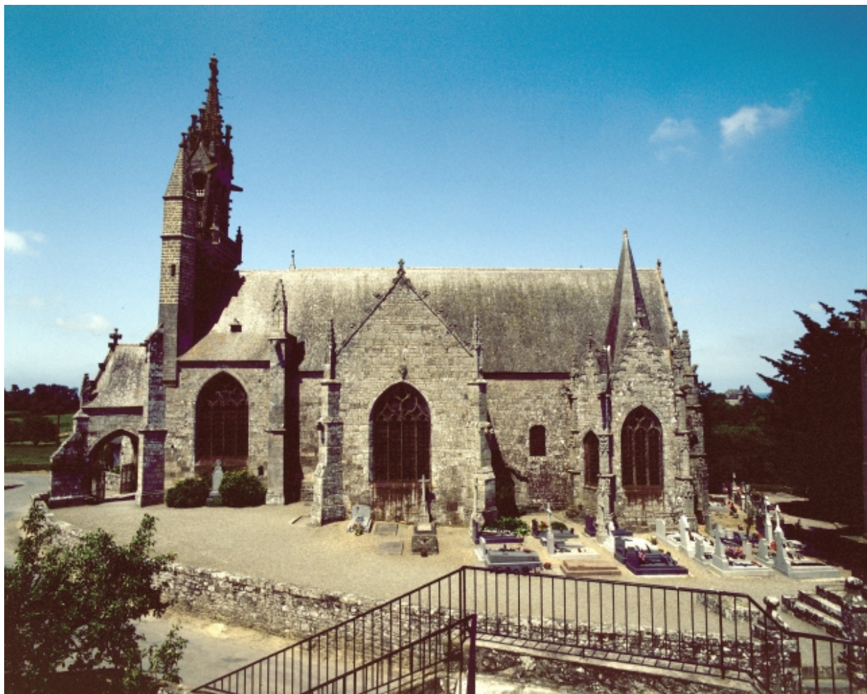
Elévation sud, partie ouest : vue générale
