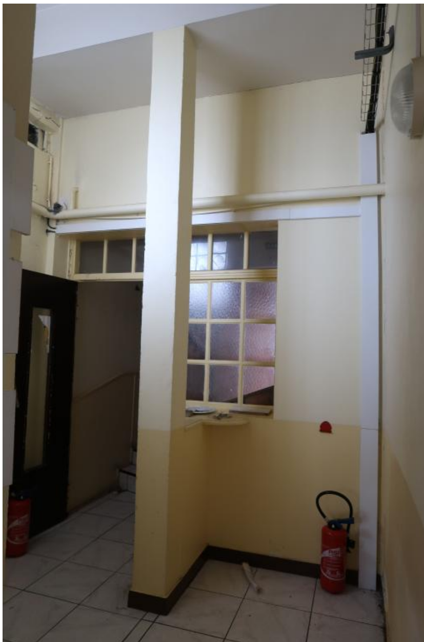
Intérieur, rez-de-chaussée, hall, partie ouest du bâtiment
