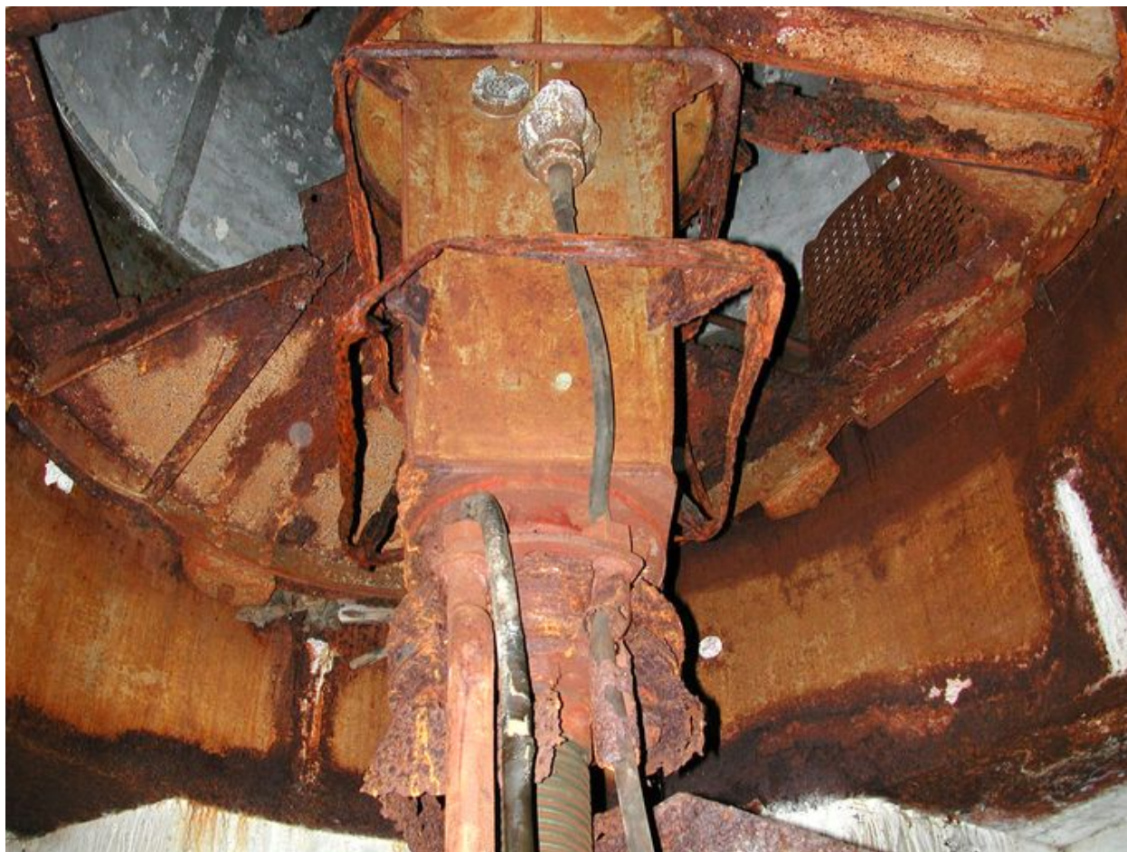
Vue intérieure : cloche blindée (état en 2003)
