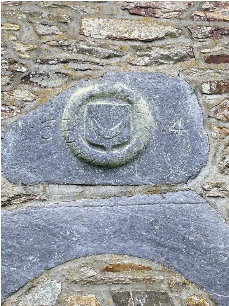
Linteau porte murée, vue ouest
