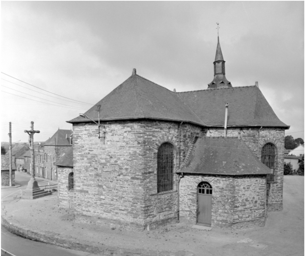
Elévation Est : vue générale
