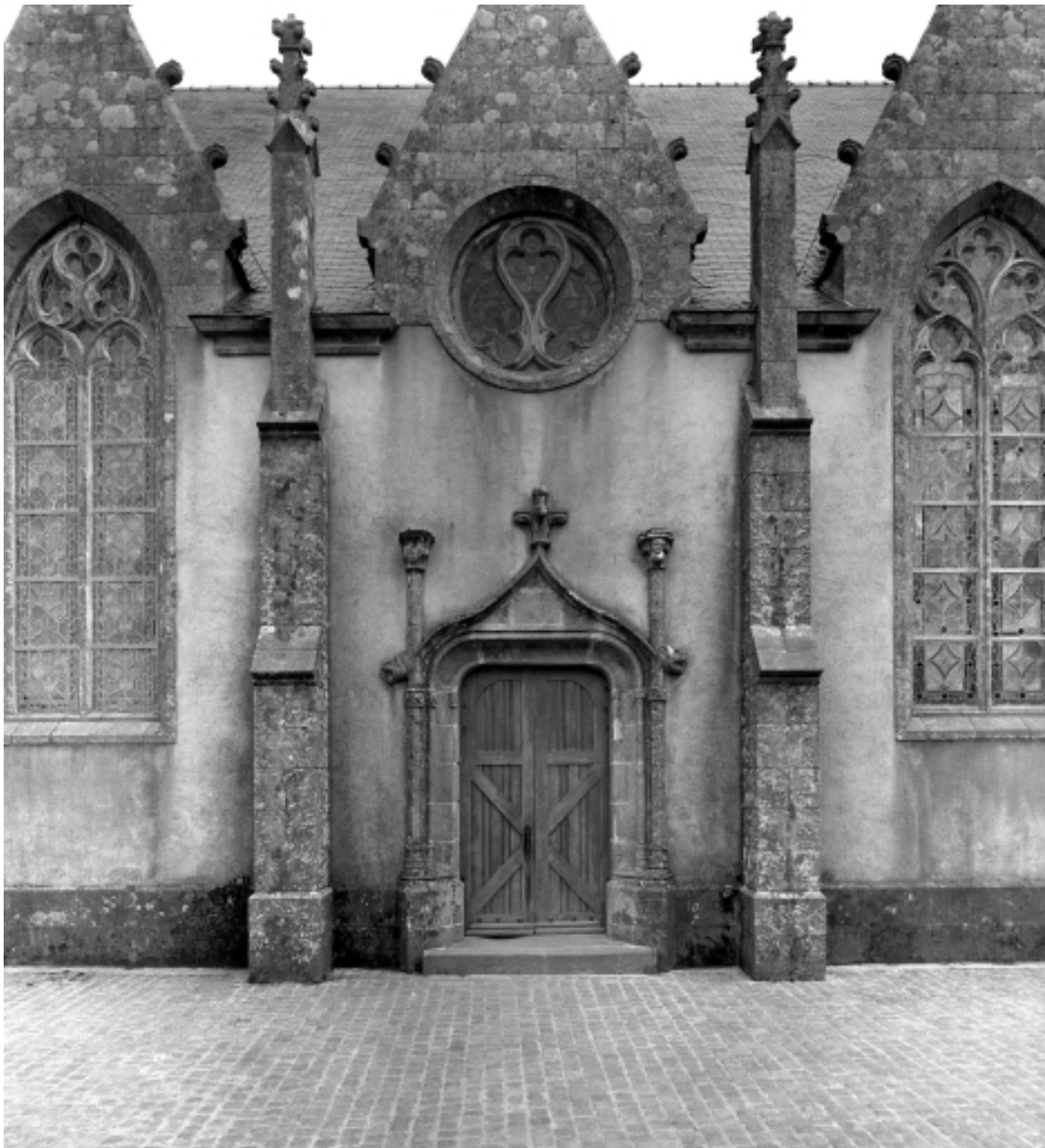
Plonévez-Porzay, église paroissiale Saint-Miliau : façade nord, détail 3ème travée, état en 1970
