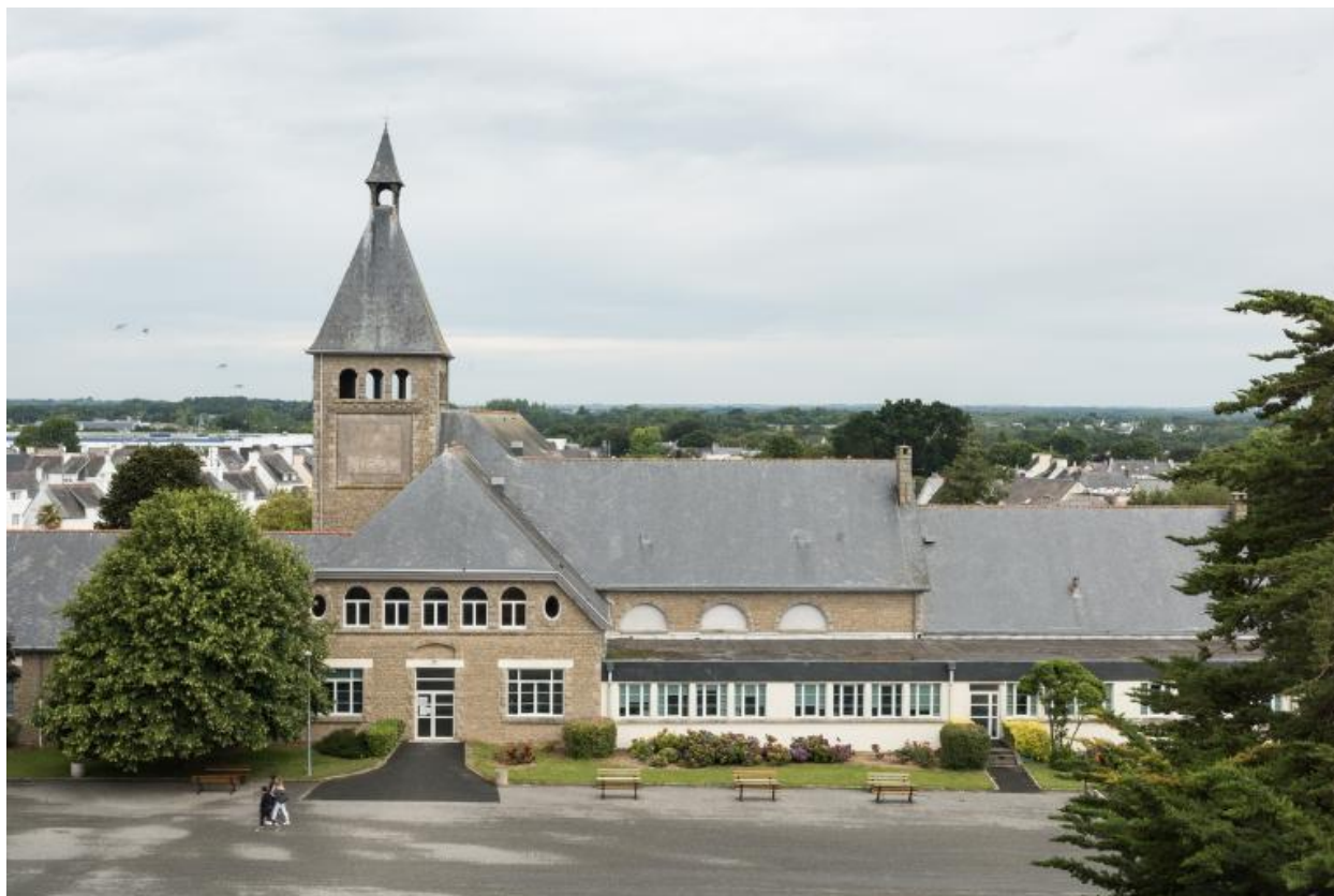
Vue d'ensemble partielle prise du sud (depuis un étage de l'externat de 1961). Georges-Robert Lefort, architecte, 1929.
