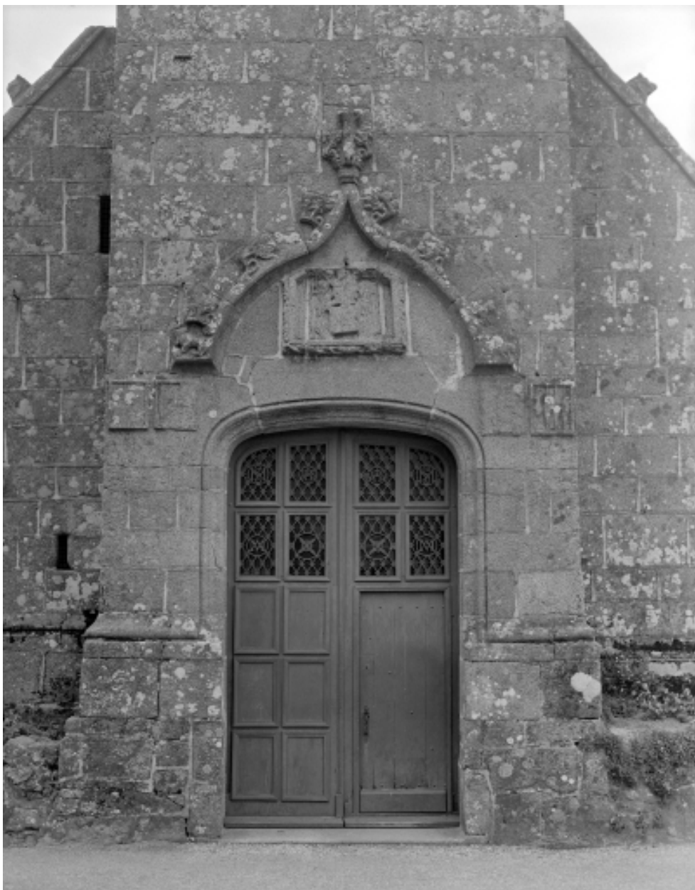
Elévation Ouest, porte principale : vue générale
