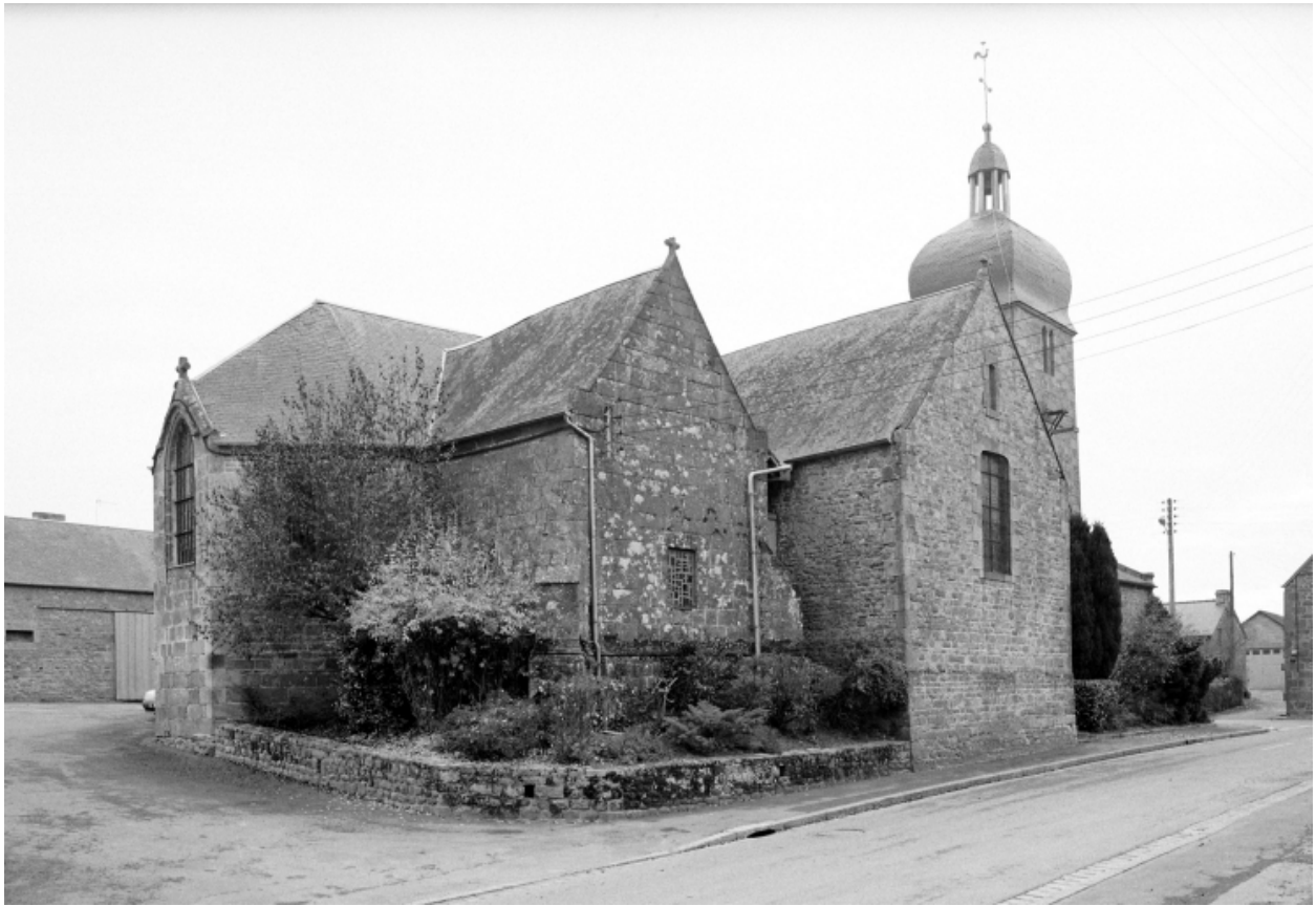
Elévation Nord-Est : vue générale
