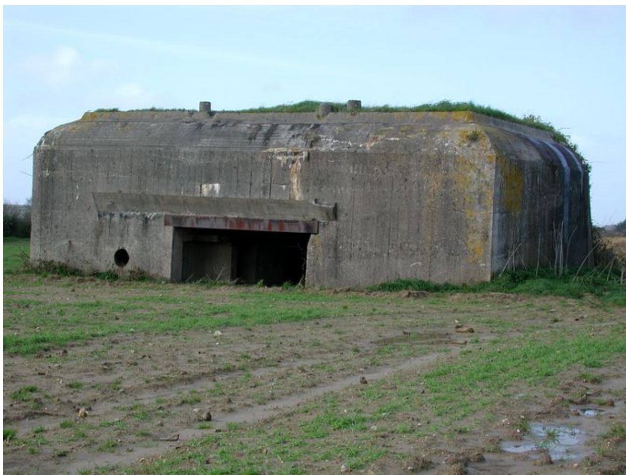
Vue générale de la casemate est depuis le sud-est : entrée (état en 2002)
