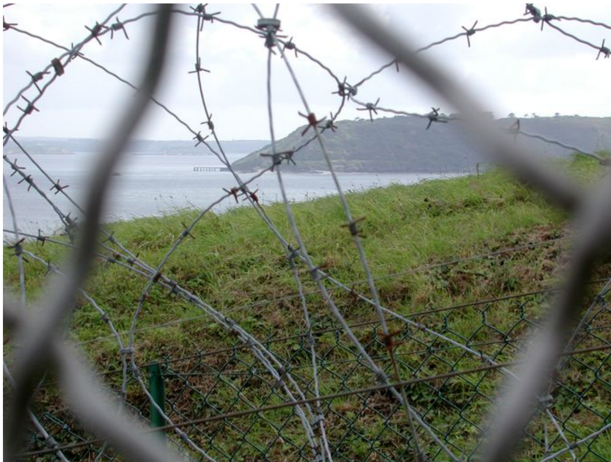
Vue du parc à carburant de Maison Blanche : clôture (depuis l'extérieur)
