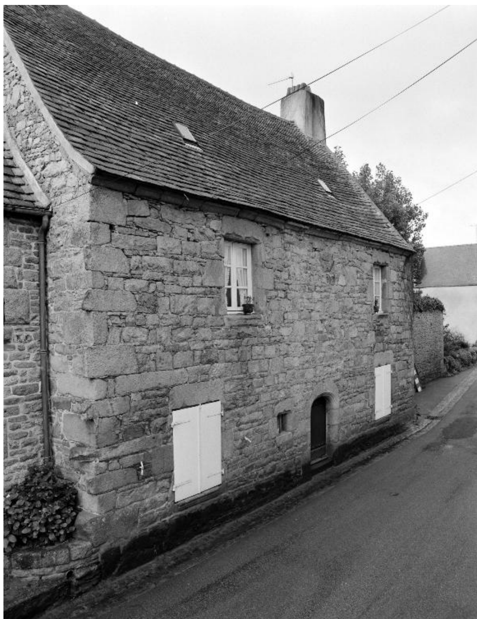
20, rue Joseph Viala, élévation nord, vue générale
