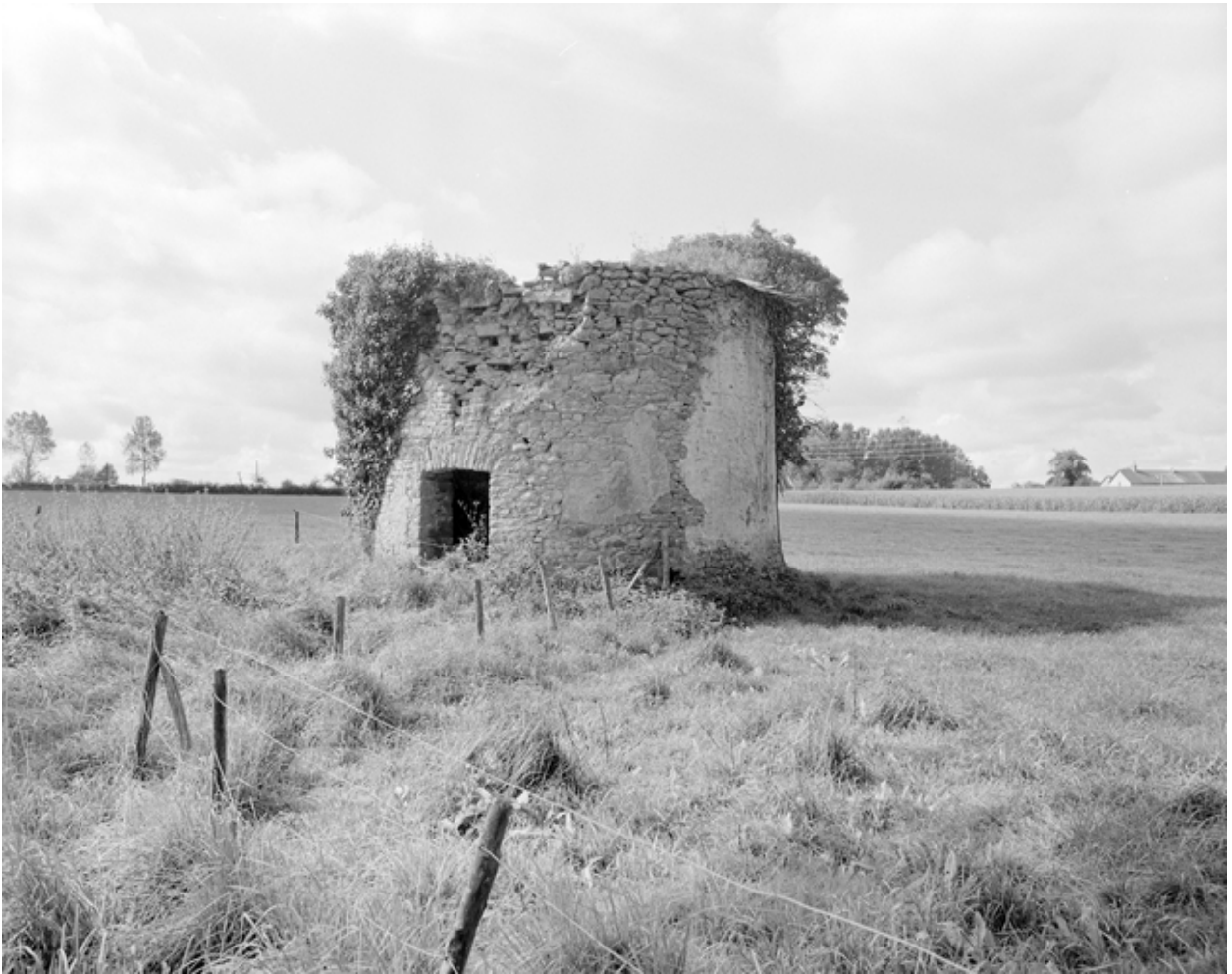
Colombier : vue générale sud-est.
