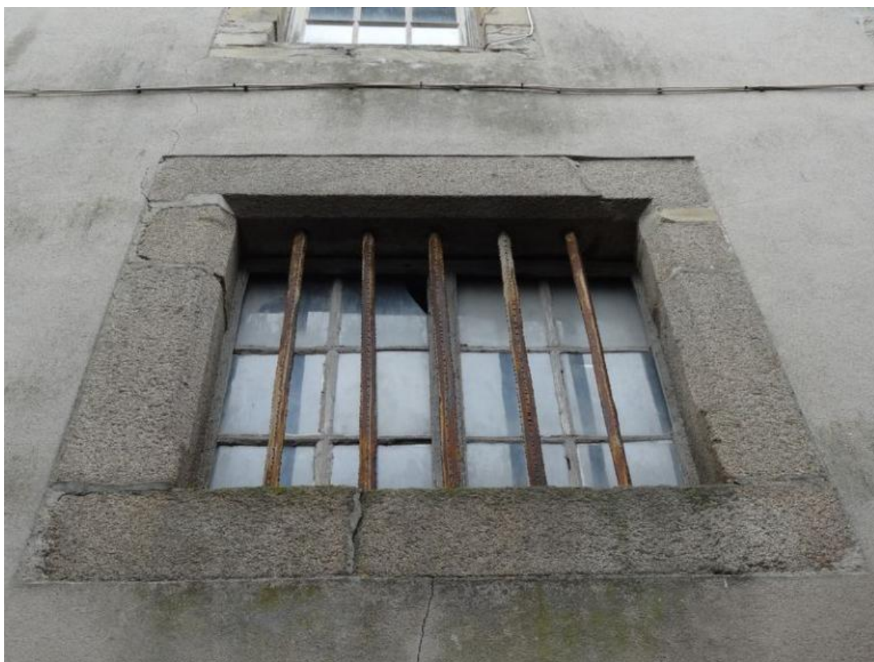
Fenêtre du rez-de-chaussée de la façade ouest
