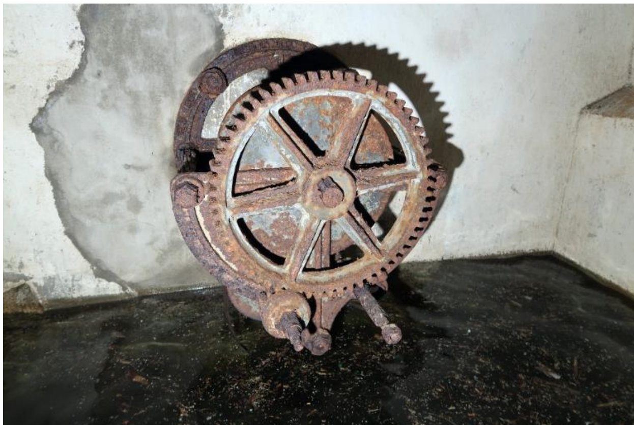
Vue du treuil manuel à tambour du vestibule côté escalier
