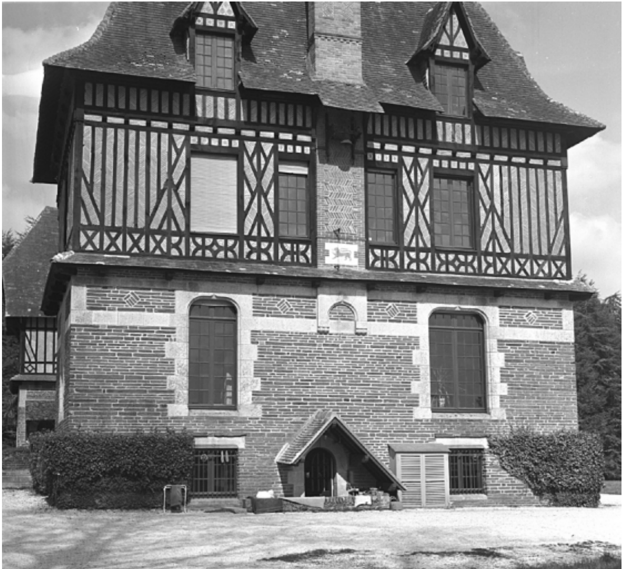
Détail : façade sud
