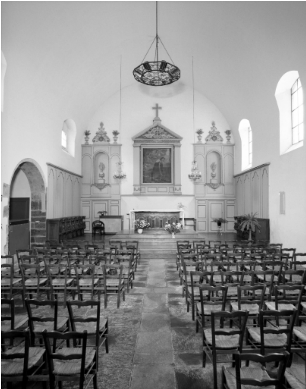
Intérieur : vue générale vers le chœur
