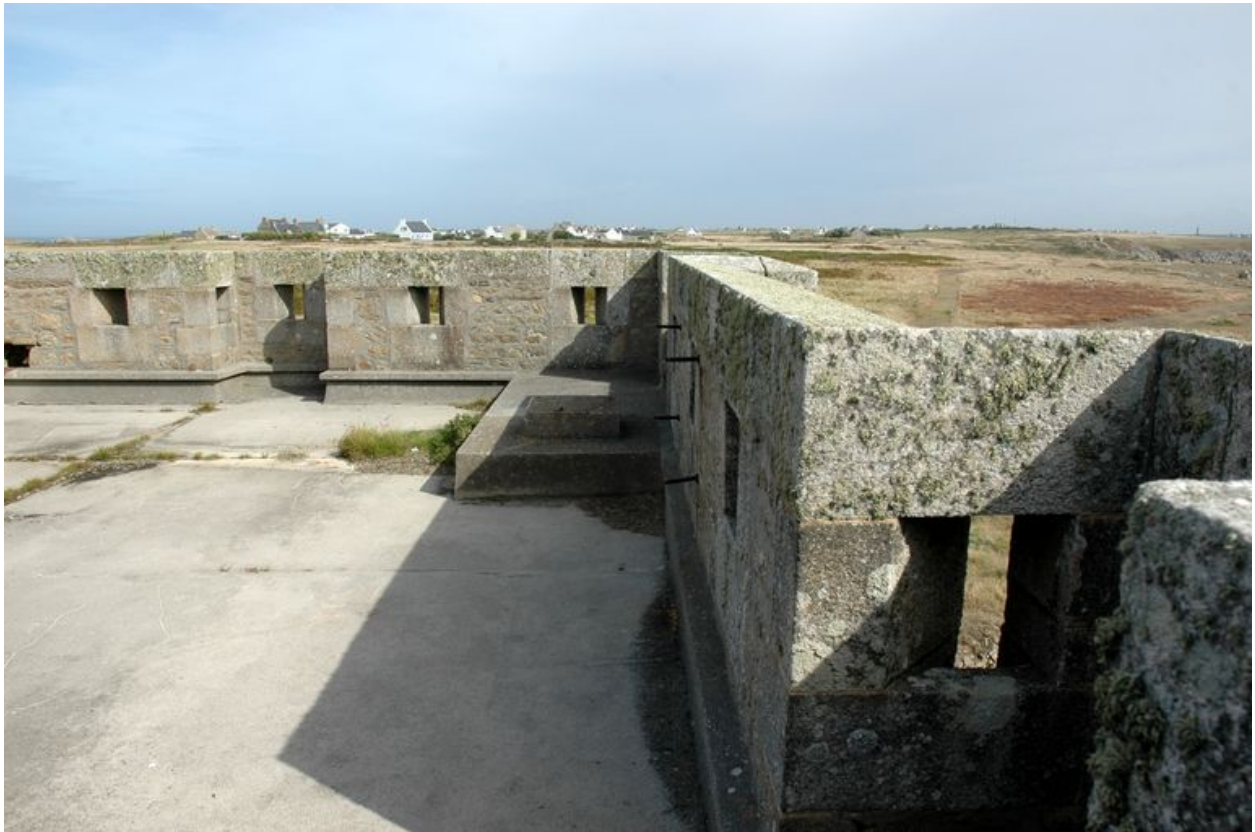
Vue du réduit de batterie de côte de Loqueltas. La terrasse est dotée de huit bretèches et créneaux de fusillade
