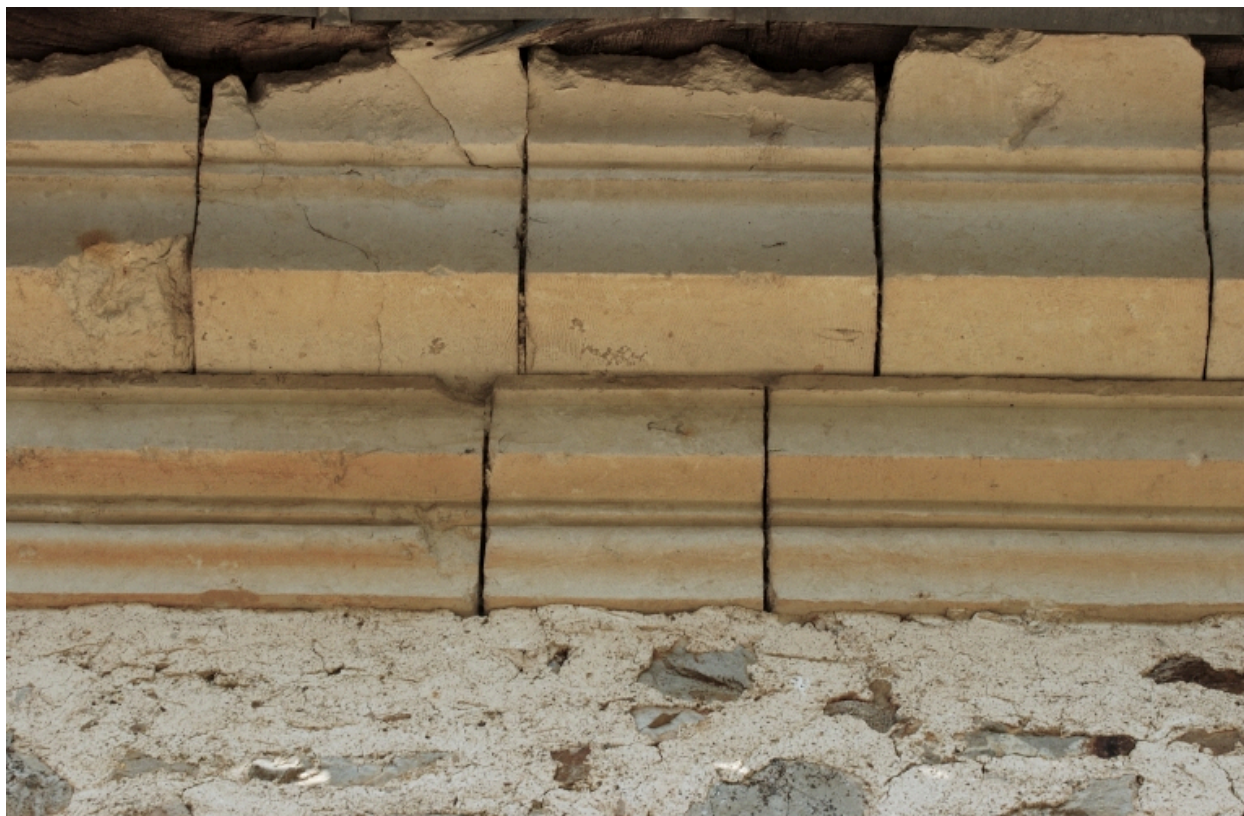
Corniche en pierre calcaire : tuffeau
