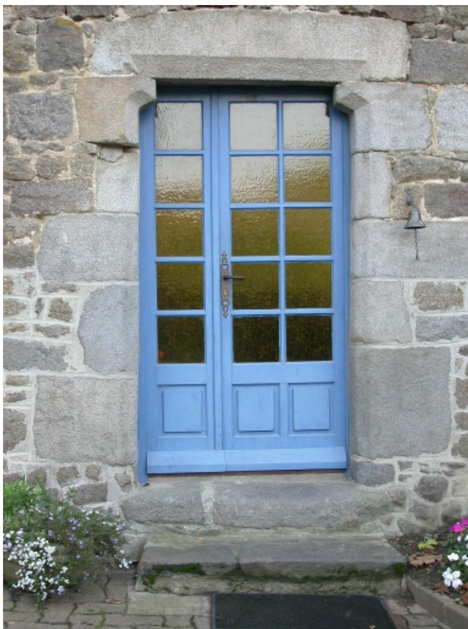
Détail de la porte du logis
