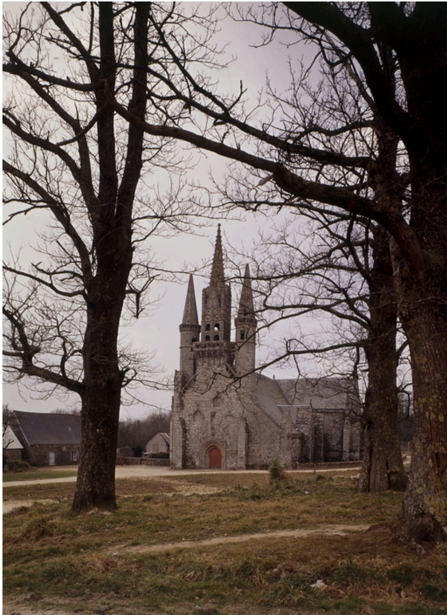
Vue générale prise de nord-ouest.
