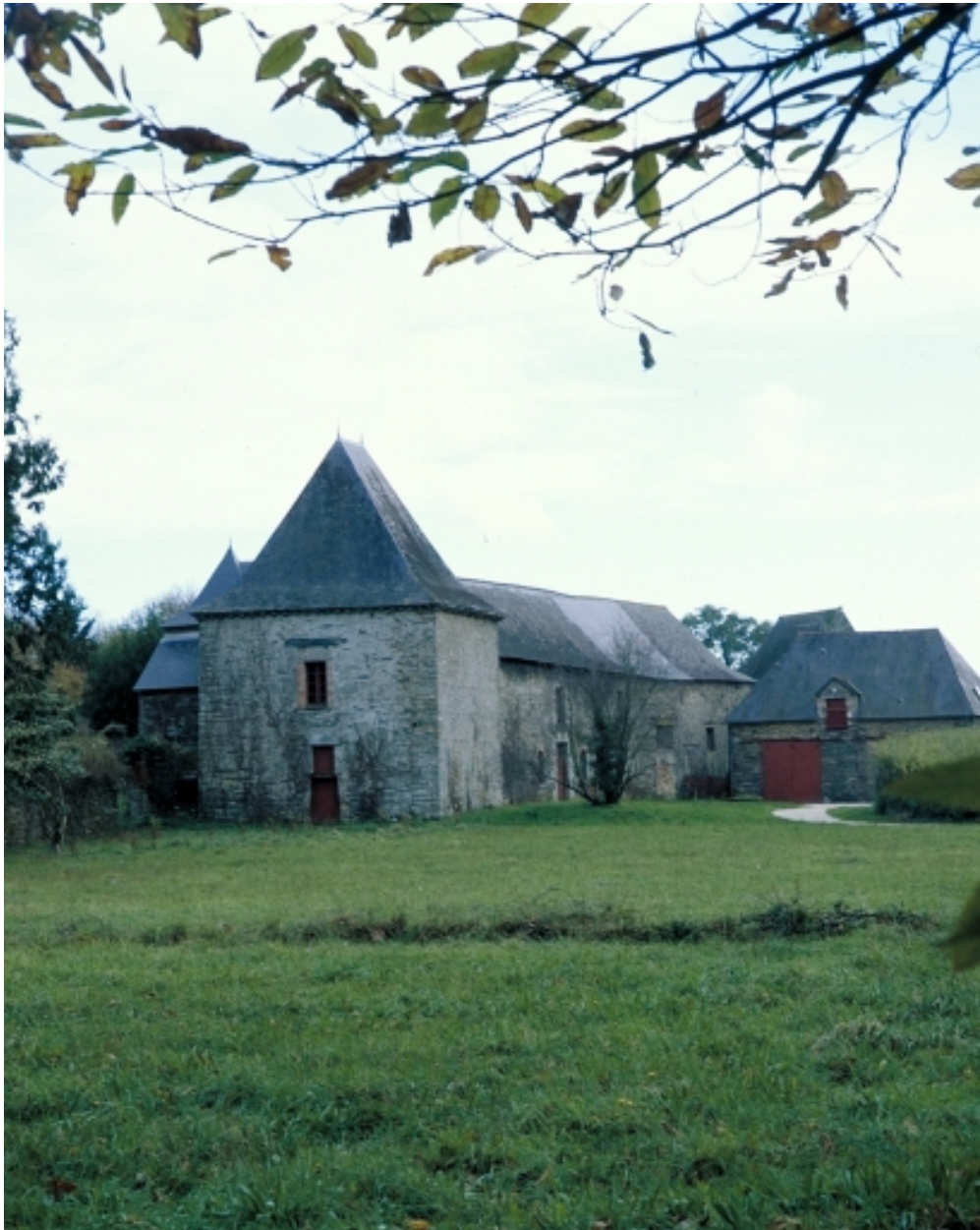
Ancien manoir : vue générale nord-ouest
