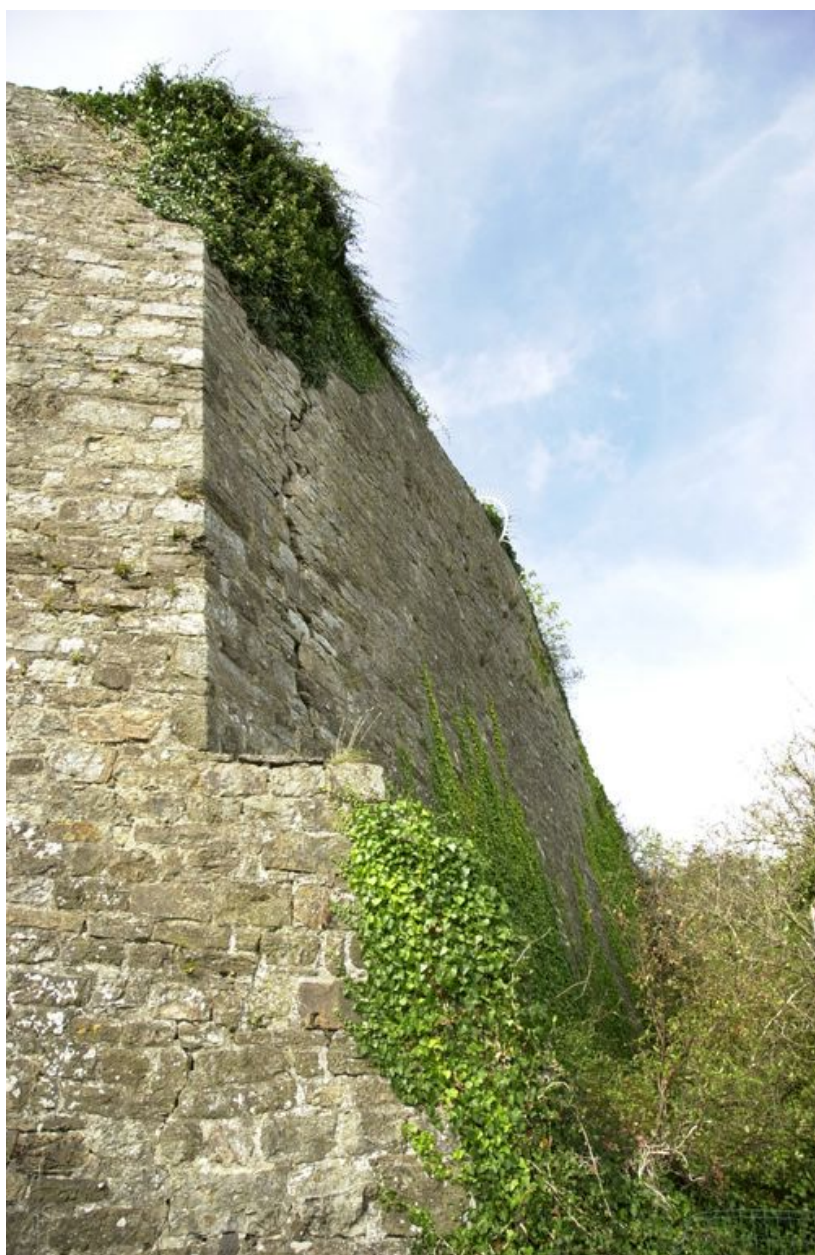
Vue du fort de Lanvéoc : demi-bastion de l'extrémité est, détail du liaisonnement du parement
