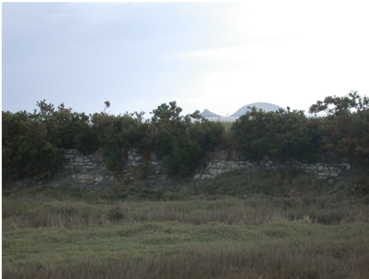
Vue du mur en soubassement du sentier de Cruckin
