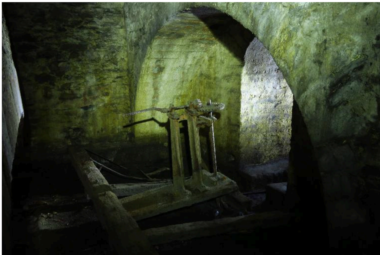
Le Palais, enceinte urbaine, porte de Bangor, chambre de manoeuvre du pont coulissant.
