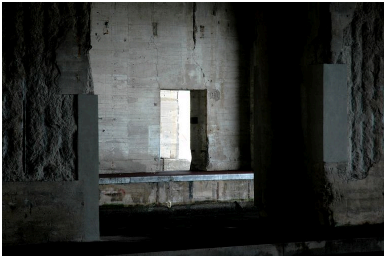
Vue de l'intérieur de la base de sous-marins
