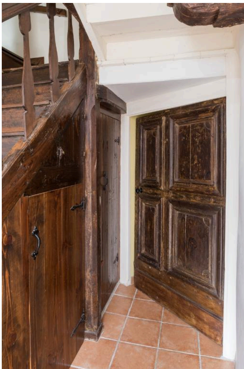
Logis ouest, vestibule d'entrée, vue générale de la porte menant à l'appentis postérieur
