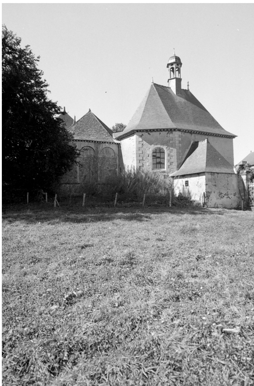
Chapelle, vue générale sud est.
