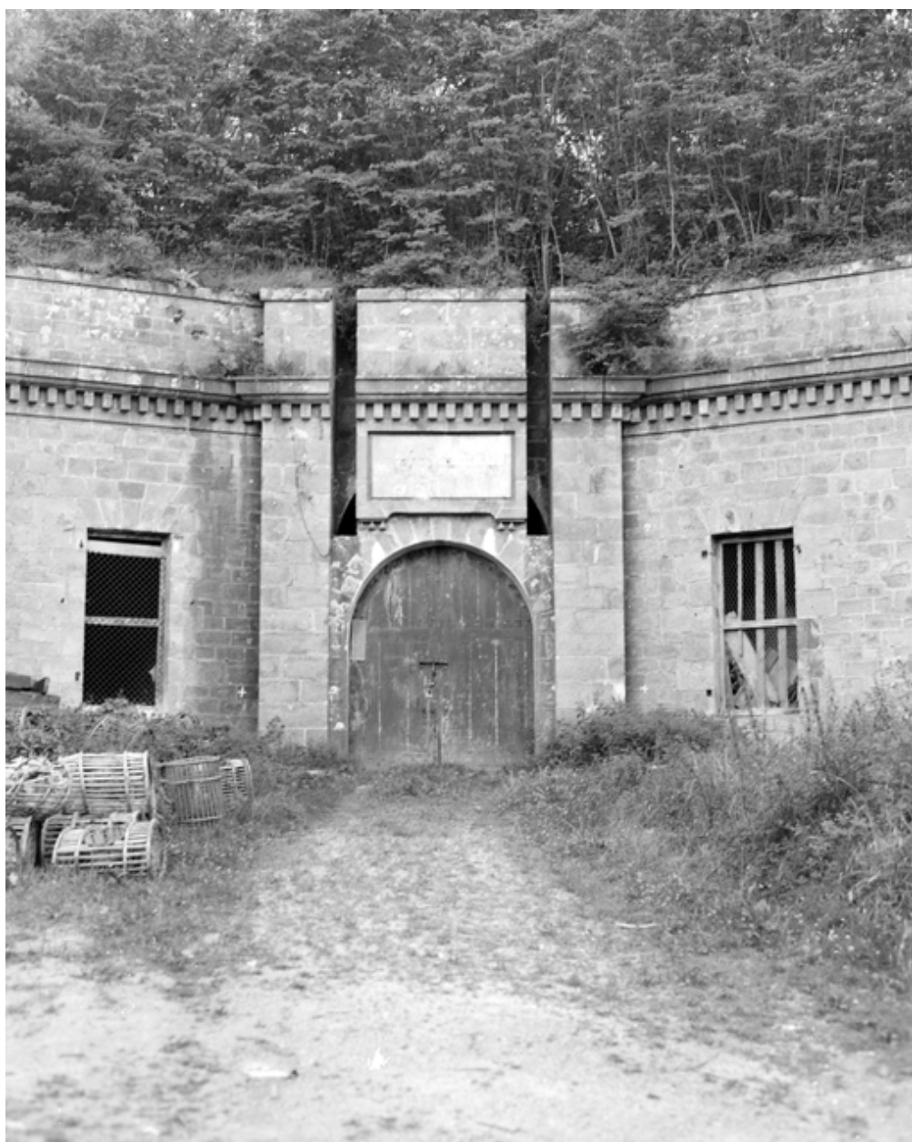
Enceinte de ville - Réduit B, détail porte
