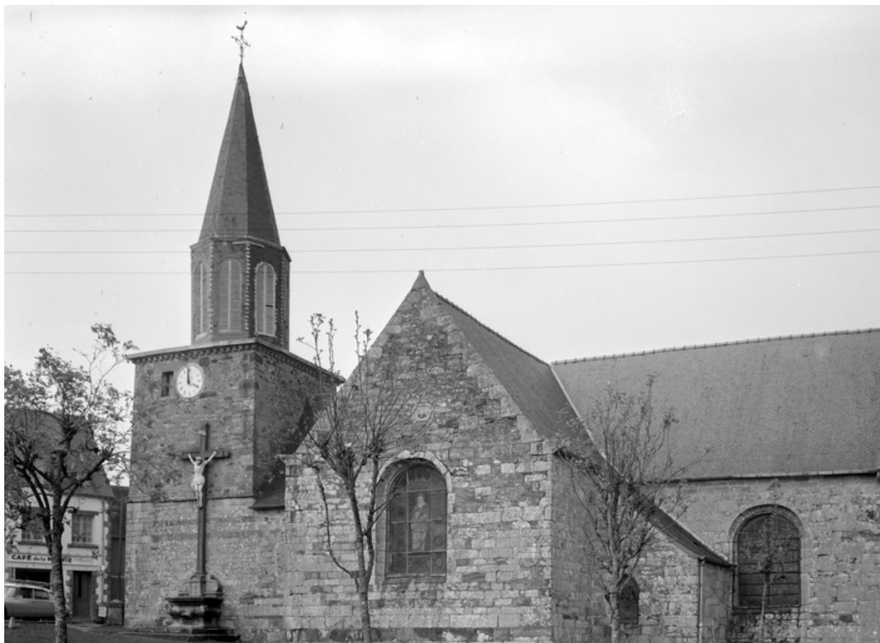
Vue d'ensemble de la façade nord
