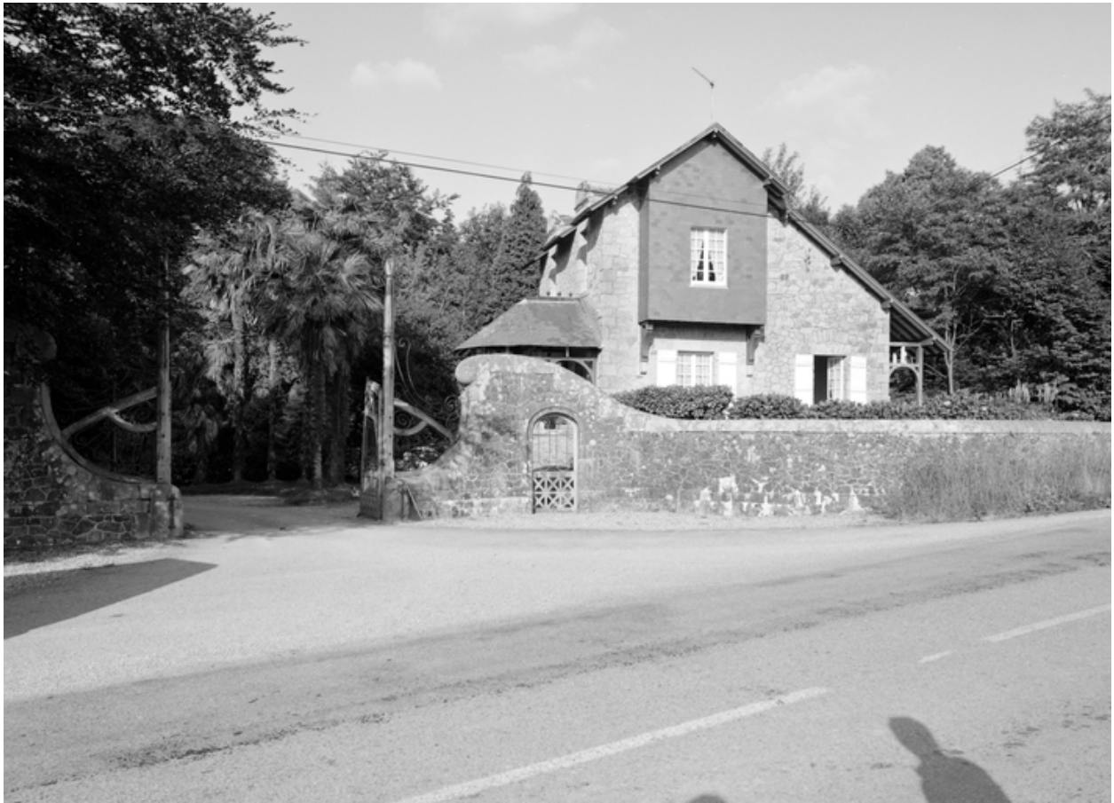
Pavillon d'entrée, vue générale.
