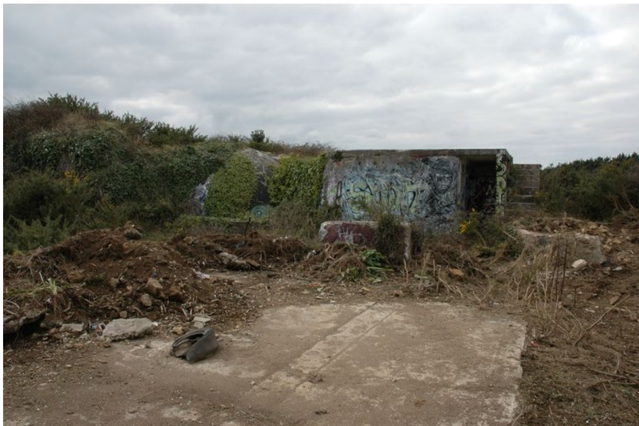
Vue de situation : sol en dalle de béton (état en 2005)
