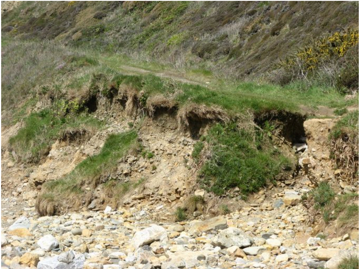
Détail de la rampe du site portuaire de Porzh Koubou
