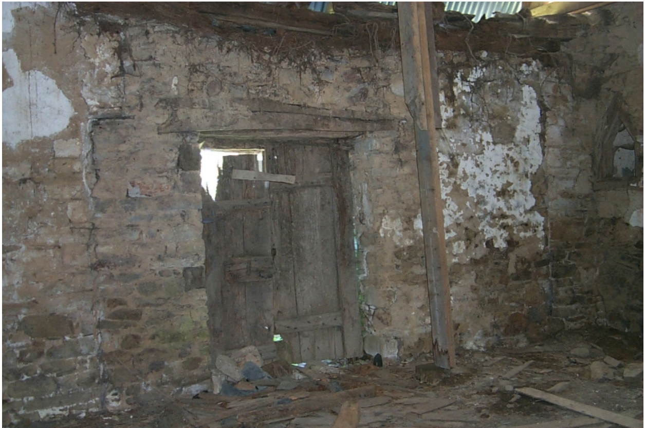
Intérieur, mur nord, porte
