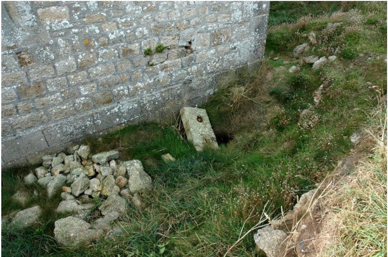
Vue du réduit de batterie de côte de Loqueltas, façade orientale. Regard de la citerne
